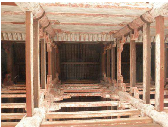
747年創建の東大寺内部骨組み(奈良)
